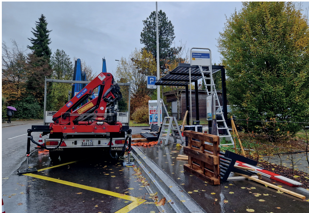
Die neuen Buswartehäuser an der Schwarzenbachstrasse werden montiert.
