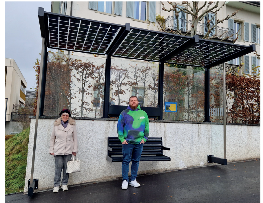
Warten auf den Bus: Gegen Wind und Wetter geschützt und dank Solarenergie nachts beleuchtet.
