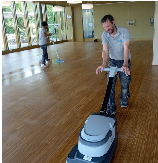
Im Erdgeschoss Haus C wird der Parkettboden frisch geölt.
