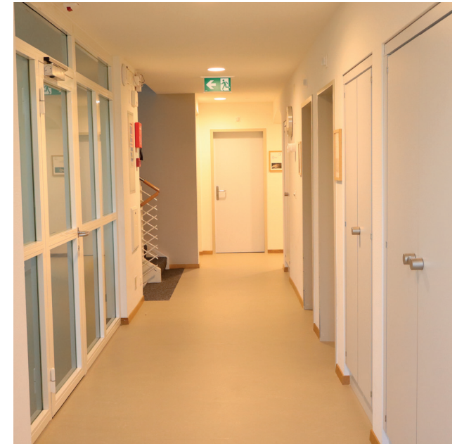
Die frischen Korridor-Böden in Haus A und B überzeugen durch den warmen Farbton.
