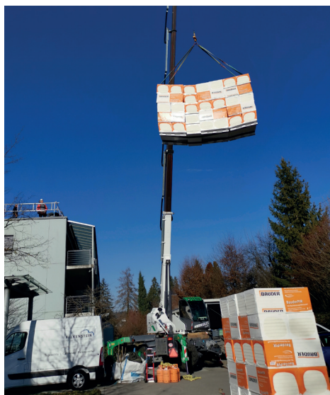
Auf dem Dach Haus B wird eine zusätzliche Dämmschicht eingebaut.
