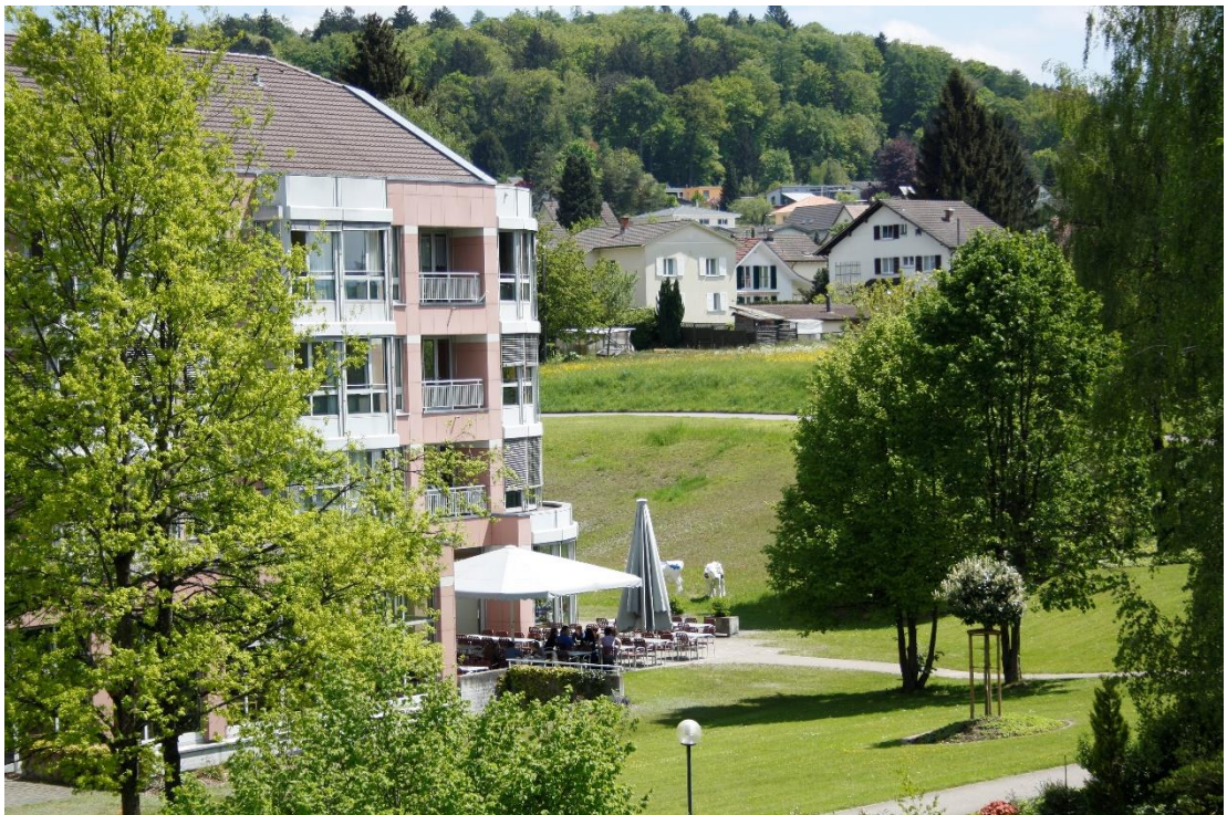
Ebenfalls ein Ort der Begegnung sind die Cafeteria-Terrasse sowie der grosszügige Park des Asana Spital Menziken
